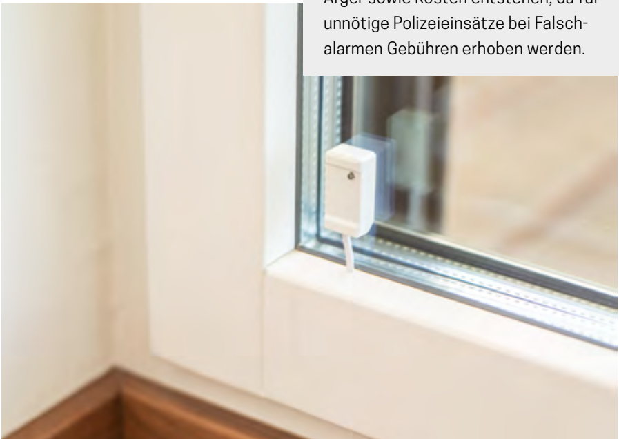
^ Außenhautüberwachung mit einem Glasbruchmelder
