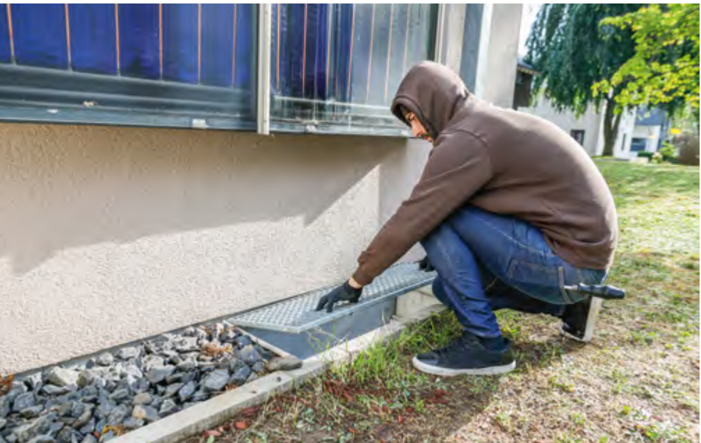
^ Ungesicherter Kellerlichtschacht
